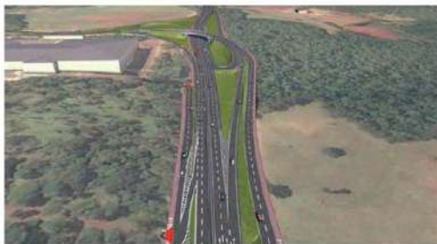
Obras da Perimetral Leste avançam no Porto Meira
