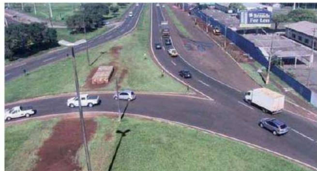
Trincheira no trevo do CTG Charrua precisa ser construída com urgência
